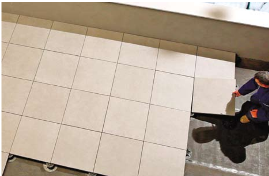
Układanie płyt na wspornikach, w tzw. technologii „tarasu wentylowanego”
