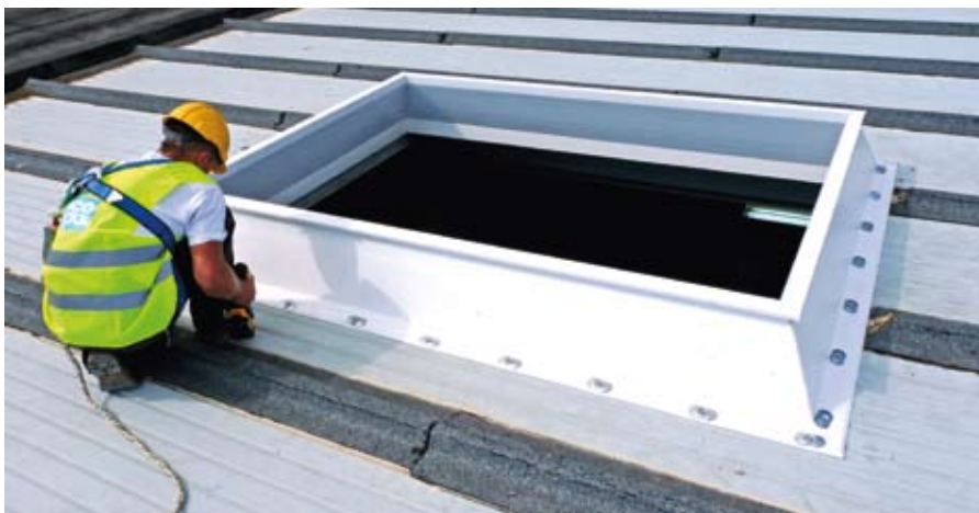
Pokrycia świetlików i klap dymowych montowane są na podstawach z tłoczonego PVC
