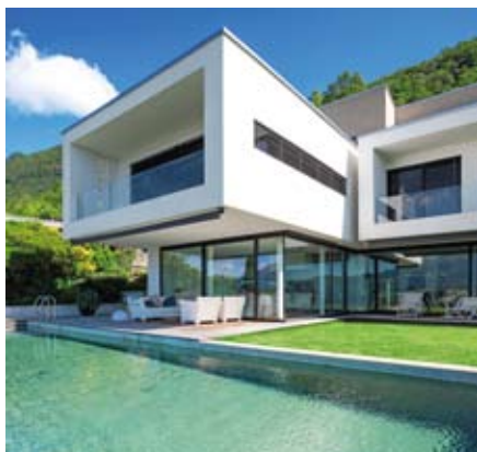
Duże przeszklenia wzbogacają nie tylko wnętrze, ale także elewację budynku
